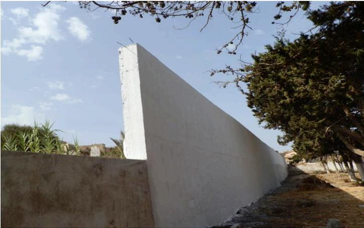
Il faut finir ce mur par surélévation de 50M de long sur 2m de hauteur par une double rangée de 2 moellons avec poteaux intermédiaires, après réfection de la semelle, le chaînage, le montage d'une corniche.
