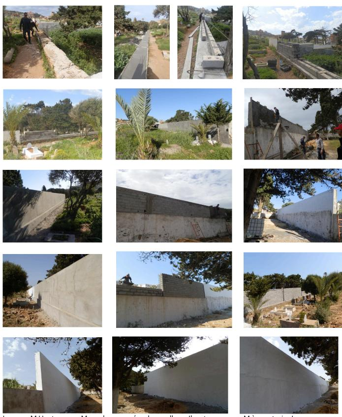
Long:53 M Haut:1m50-2M sur deux rangées de moellons. Il reste encore 50M à construire!
