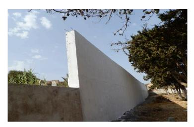
Il faut finir ce mur par <u>surélévation de 50M de long sur 2m de hauteur</u> par une double rangée de 2 moellons avec poteaux intermédiaires, après réfection de la semelle, le chainage, le montage d'une corniche. L'ensemble sera crêpis et peint (idem que photo ci-dessus).
